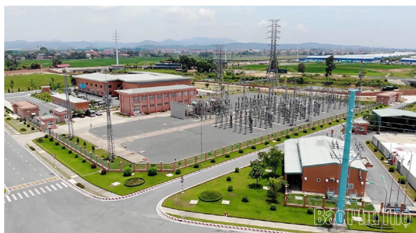
Khu công nghiệp Thăng Long Vĩnh Phúc với hệ thống hạ tầng đồng bộ, hiện đại - có vị trí chiến lược trong thu hút đầu tư.
